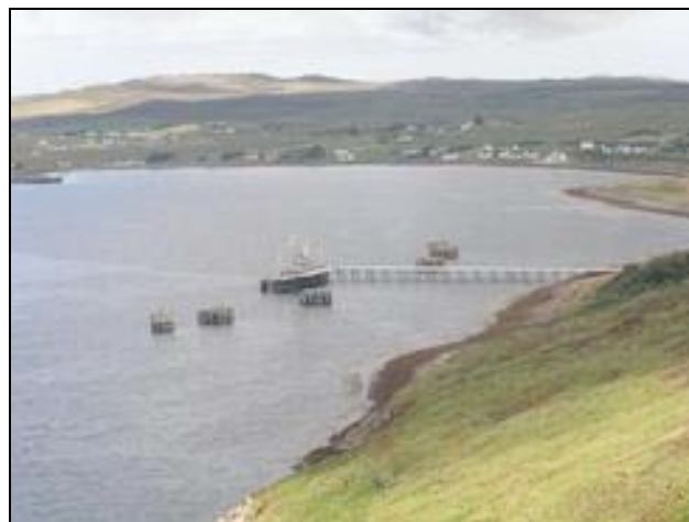
Aultbea POL jetty i
